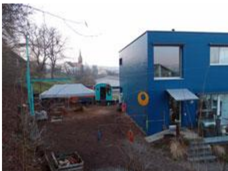
Werkplatz beim Atelierhaus
