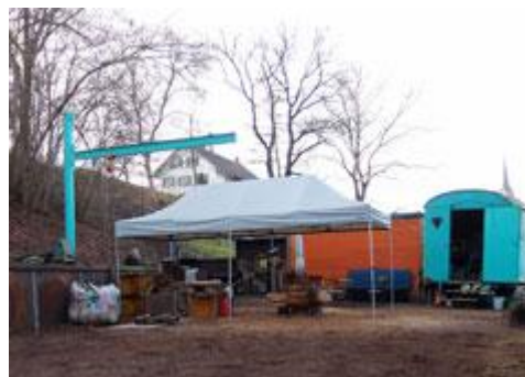
Werkplatz beim Atelierhaus
