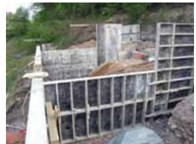
Fundament schalen
