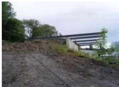
Stahlträger setzen
